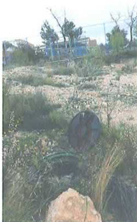
Foto 2. Pozo de conexión con la red existente
