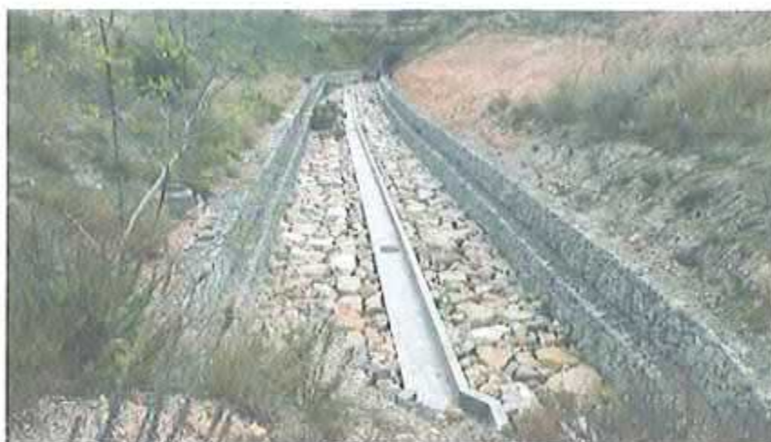
Foto 1. Conexión de la red de saneamiento en el encauzamiento. Al fondo obra de paso bajo la N-332 El entronque a la red existente se produce en un pozo de registro próximo a la calle "Partida Salt de l'Aigua", Foto 2.
