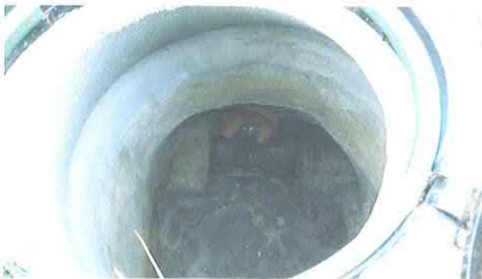
Foto 4. Conexión de la red de saneamiento del Sector PP3/1 con la red existente
